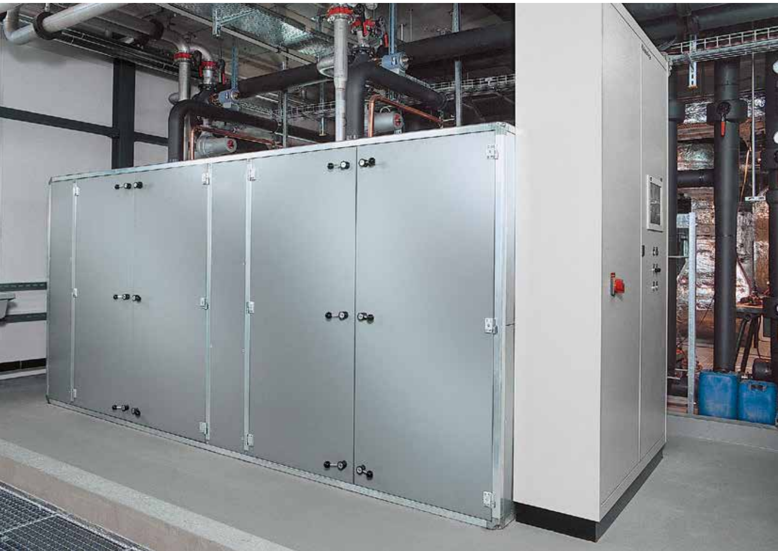
Tepelné čerpadlo voda/voda s topným výkonem 500 kW.
