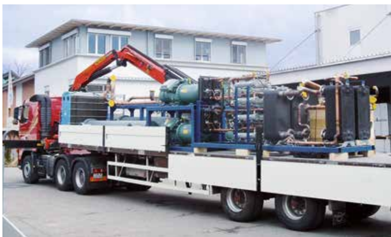
V závislosti na situaci s dopravením na místo se tepelná čerpadla Viessmann dodávají po modulech.
